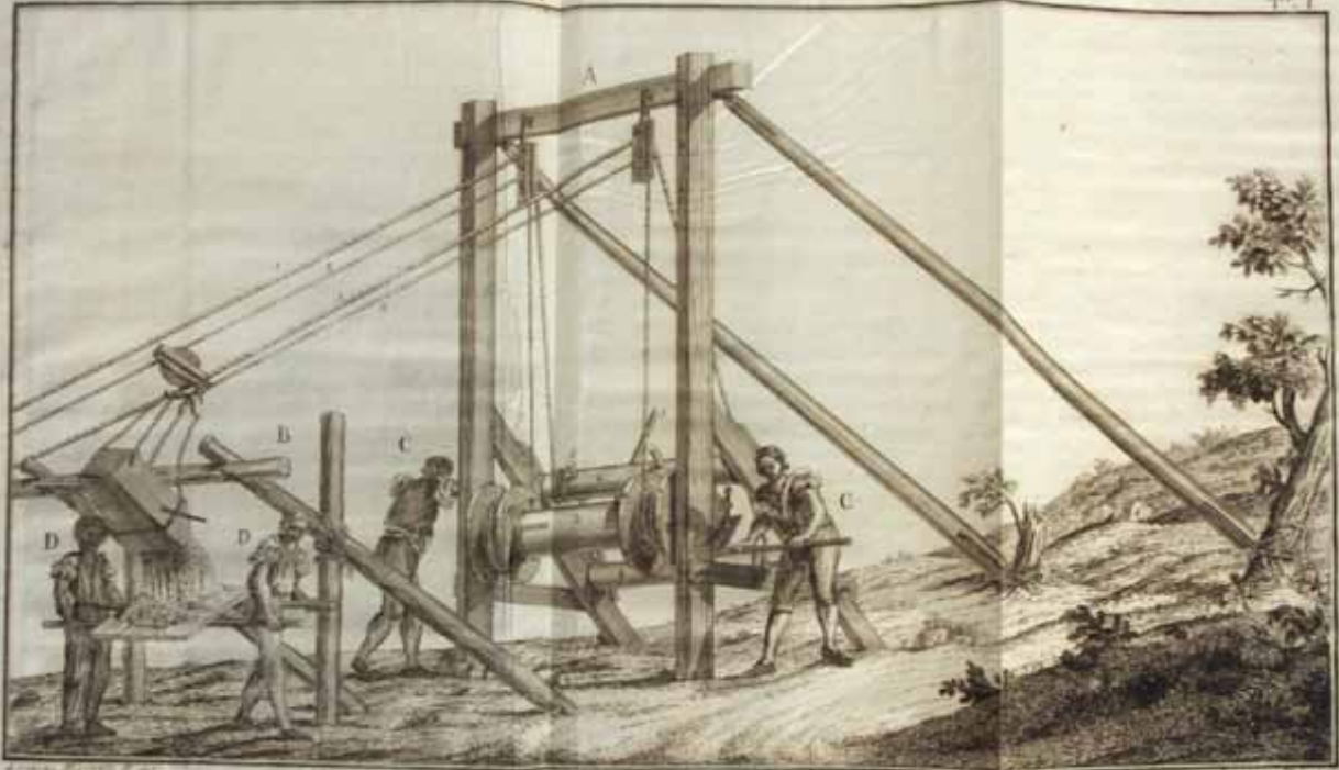
Plancher de la mine de St. Louis
